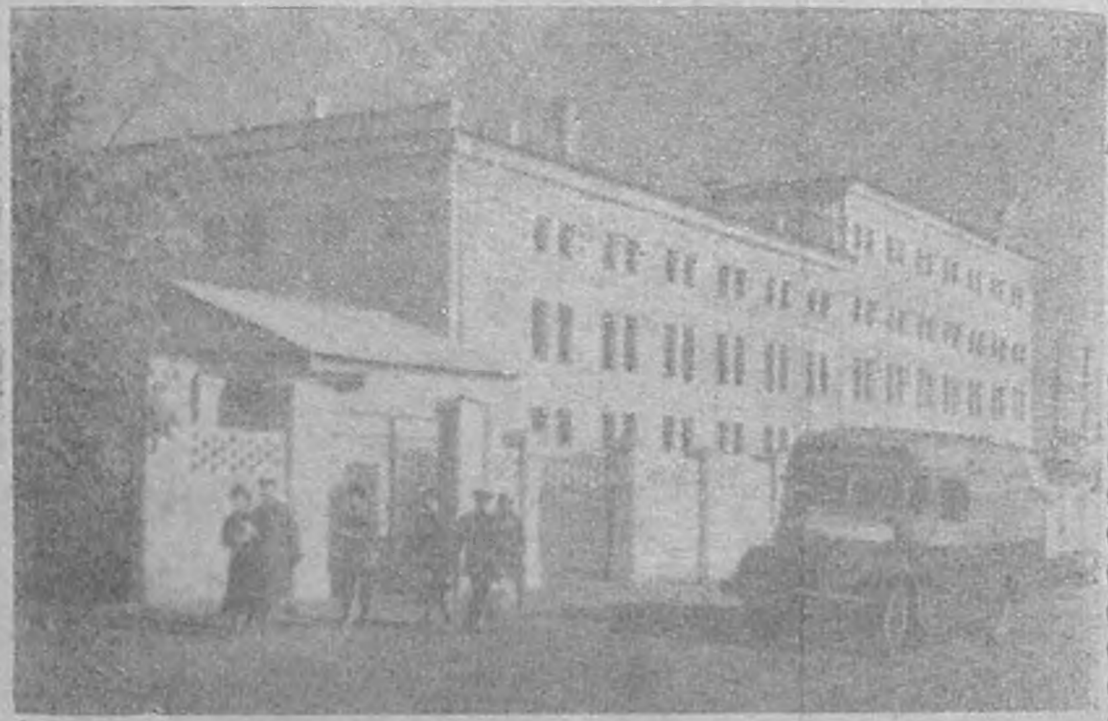
Одмг болгъдг шин завод Сталинградт тосхгдӱд дуусгдв. Эн завод техникӱр икар агсгддж. Цуг кӱдлмшнь механизмӱр болн автоматика бгднӱ. Завод суткдан 75 тонн одмг болгъна. ЗУРГ: одмг болгългъна завод.
