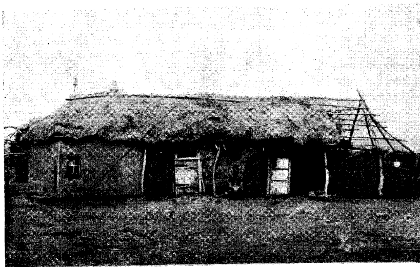
Рис. 212. Изба из одинарного плетня под одной крышей с хозяйственными постройками. Юрматынцы.
