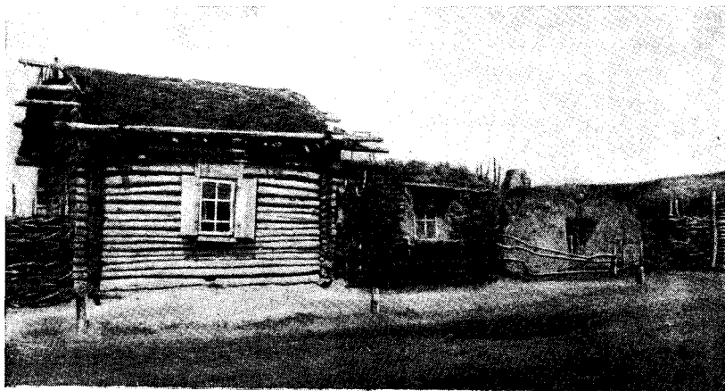
Рис. 186. Избы: бревенчатая, из двойного плетня, плетневая обмазанная глиной. К а т а й ц ы.
