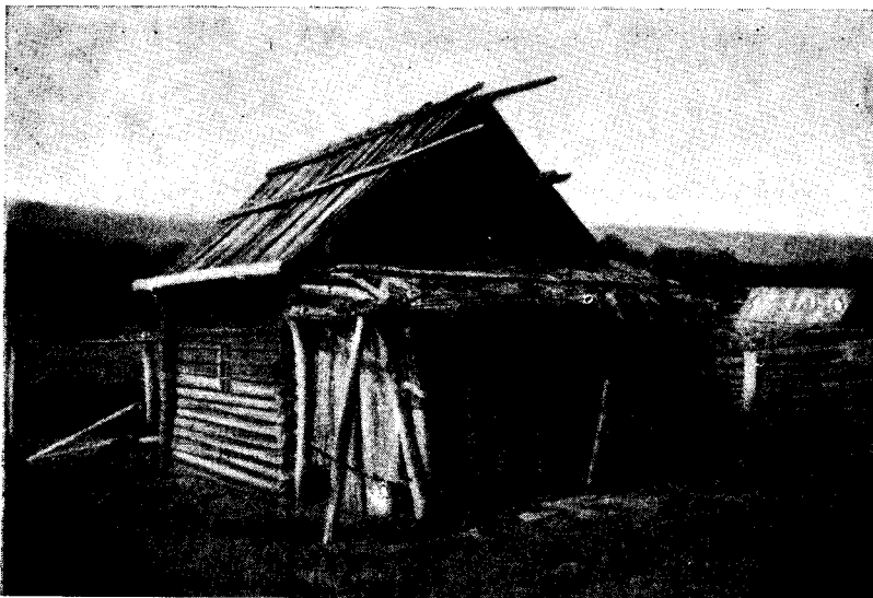
Рис. 194. Изба, покрытая драницей, с сенями из полубины. И н з е р - к а т а й ц ы.
